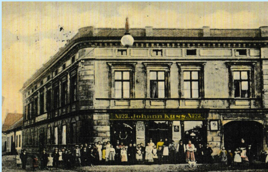
Kamienica własność rodziny Kussów. Na parterze mieścił się sklep żelazny i skład budowlany
